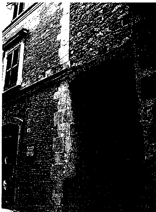
Foto 3. Guardiagrele: la muratura in pietra e in mattoni
